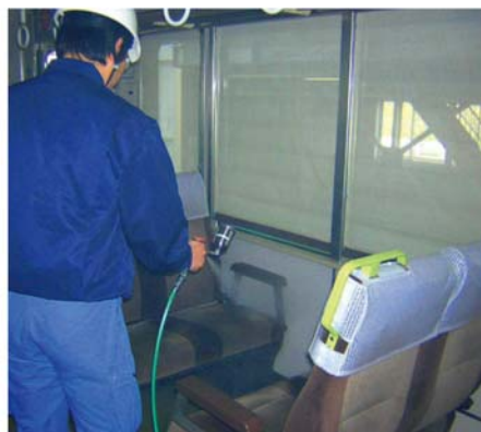
JR車内施工風景
